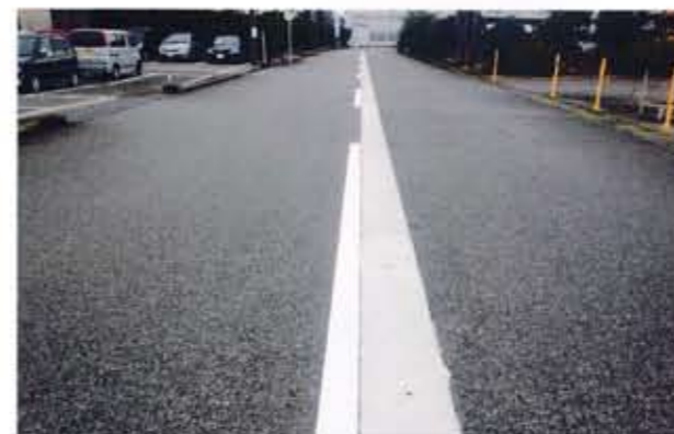
冬場の道路環境を改善した団地内の融雪装置
